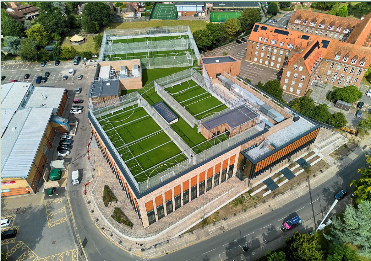
Figure 1: Passivhaus 'Eclipse Leisure Centre'
